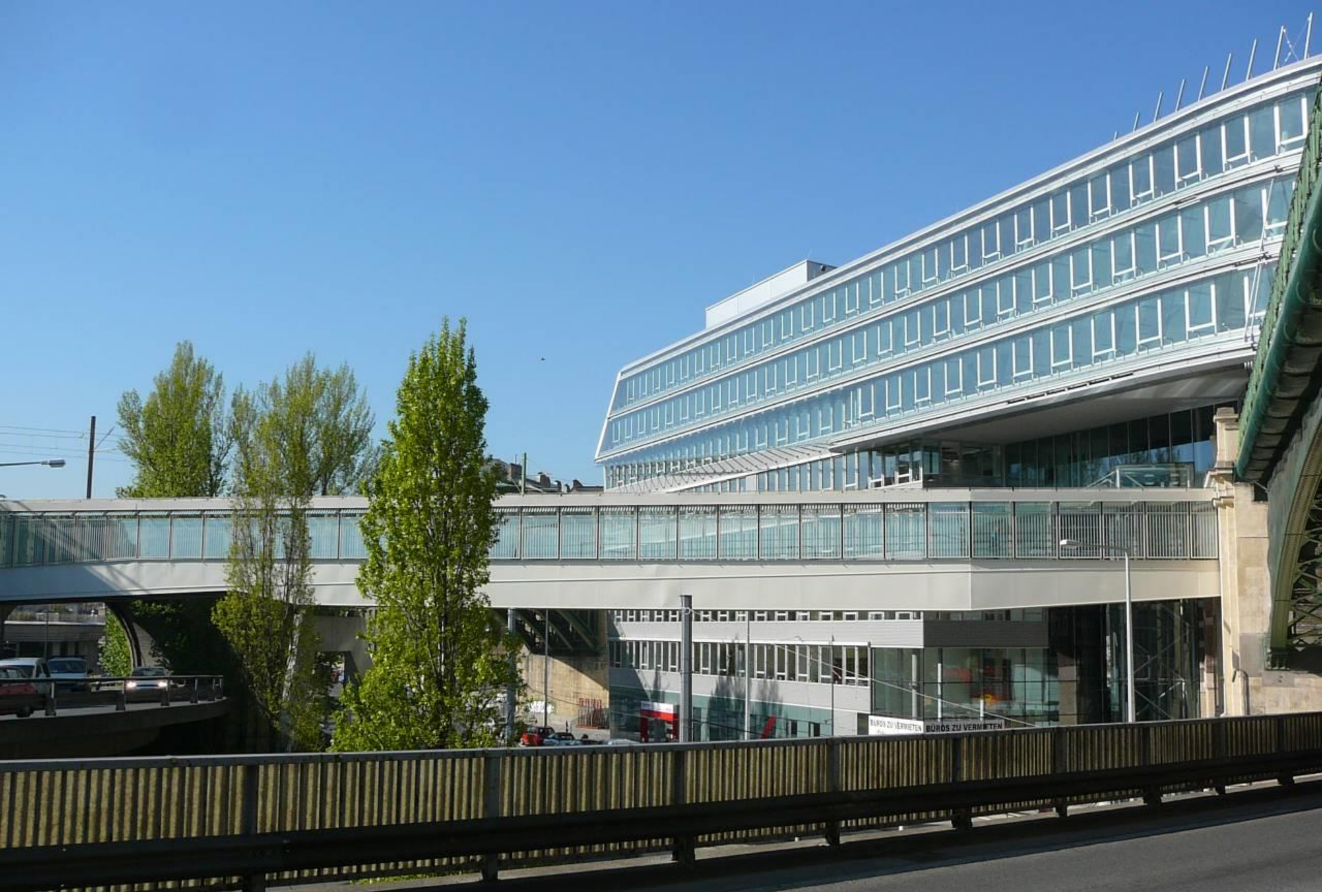
Wien 9., Skywalk Spittelau (MA29-Brücken- und Grundbau)
